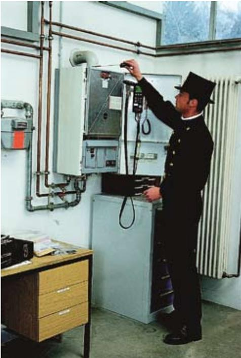
Nach den Kehr- und Überprüfungsordnungen wurden 2006 im Rahmen der Abgaswegüberprüfung an **fast 12,4 Mio. Gasfeuerungsanlagen** CO-Messungen durchgeführt.
